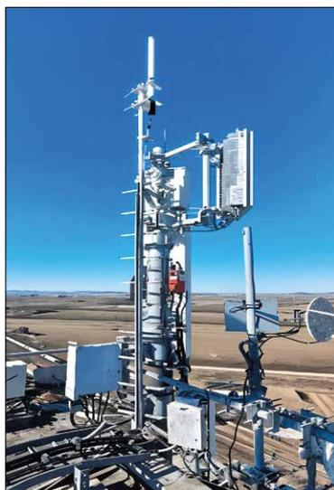
Abb. 1: LoRa-Gateway an einem Sendemast
