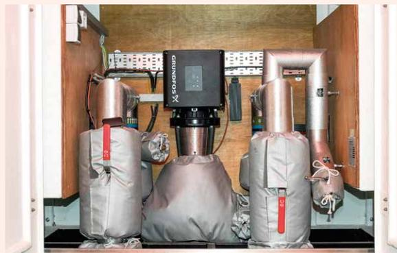
Abb. 3: Grundfos-Komplettlösung für die Einrichtung von Temperaturzonen. Der Rücklauf (rechts) wird über die Pumpe geführt und intelligent geregelt dem Vorlauf des Netzabschnittes beigemischt (links).
