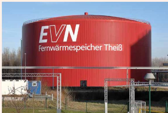
Beispiel für konventionelle Großspeicher: Der 50.000 m<sup>3</sup>-Speicher der EVN am Kraftwerksstandort TheiB, bei seiner Inbetriebnahme 2008 der größte Fernwärmespeicher Europas. Erdspeicher, wie der in der Steiermark geplante, sollen ein Vielfaches an Menge fassen.
